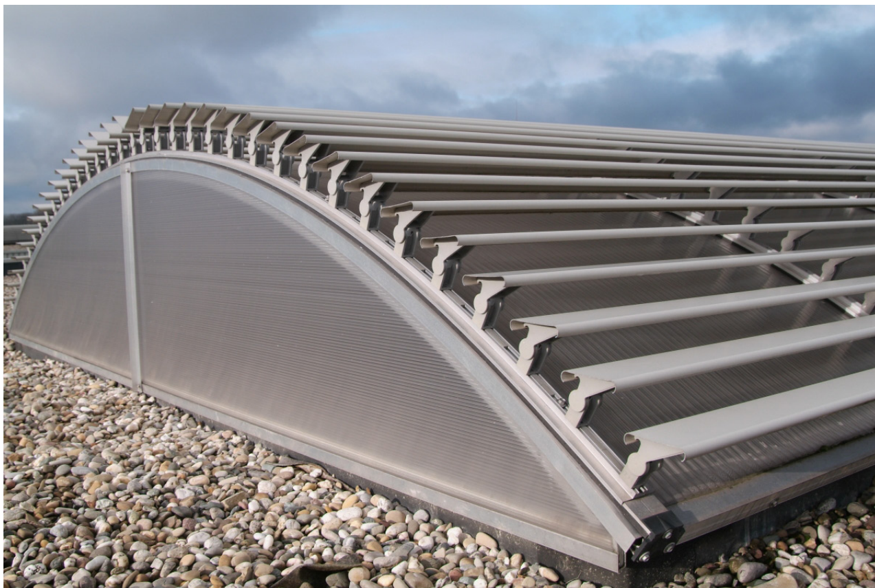
Detalle de integración de sistema de protección solar fijo Solar C sobre lucernario continuo Cosmotron.
